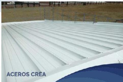
La **lámina KR-18 Pintro** se caracteriza por ser un perfil estructural de acero y un sistema de cubierta, se trata de un procedimiento versátil SSR acanalado y engargolado mecánicamente en obra.
